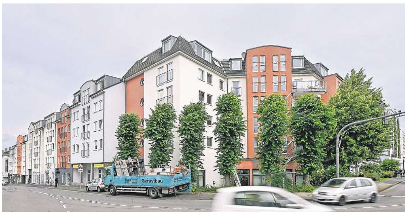
Ein Eigentümer dreier Wohnungen im Appartementhaus an der Ecke Tannenbergstraße/Ecke Hoefstraße schildert üble Zustände.
